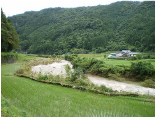
川の堰が破壊されて取水できない
