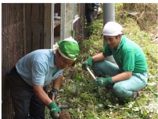
急遽東京から駆けつけた東都生協の 野地、奥山両部長が側溝の泥出し作業
