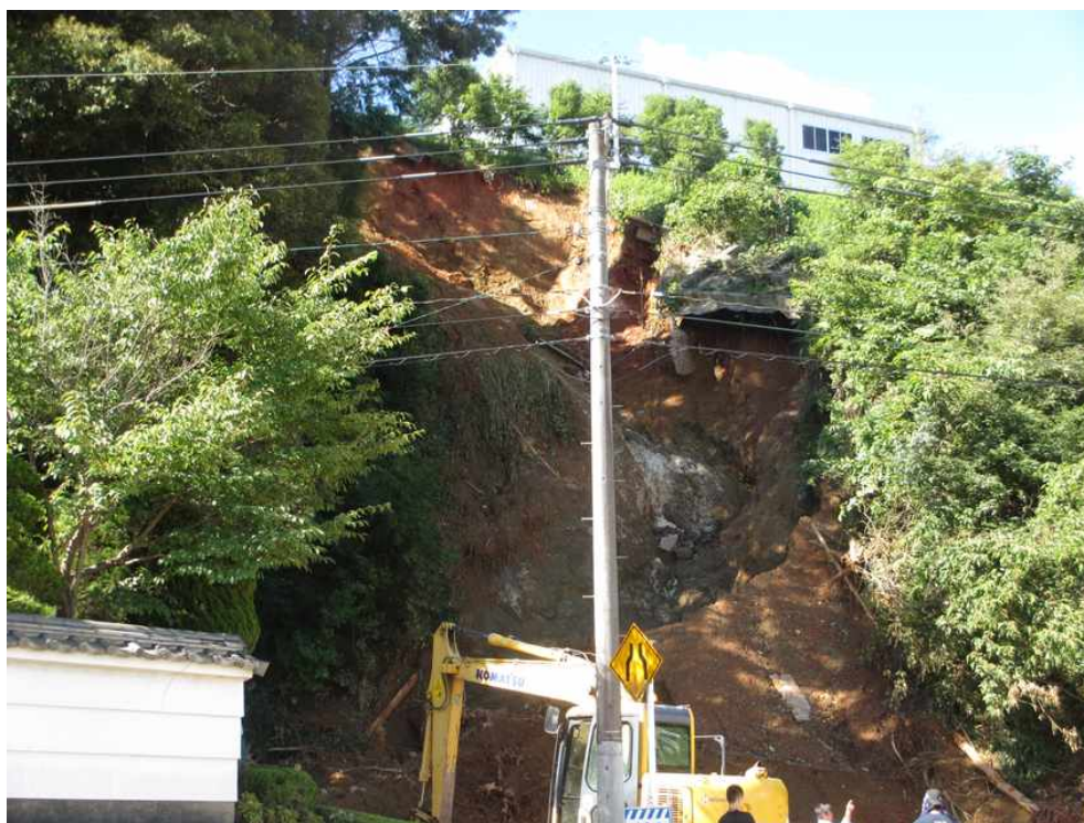
農協の農産加工工場「グリーンパック」の土手が大規模に土砂崩れ。がけの上が工場
