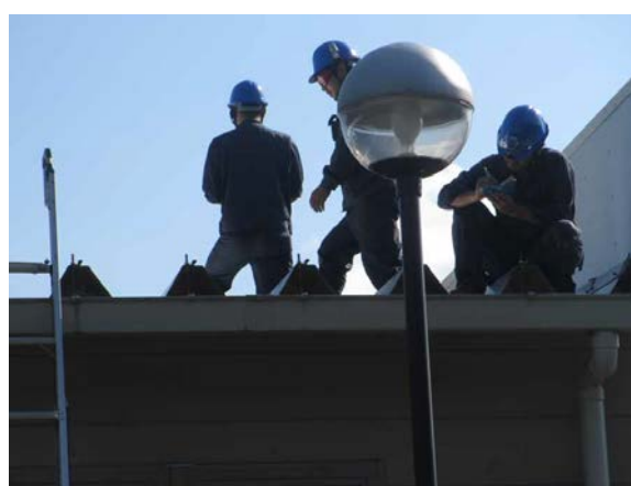
念のため北向きの屋根も設置可能性を調査
