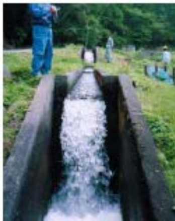
図2 水車設置場所
