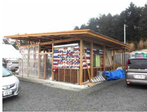
座敷、調理場などを備えた多目的交流施設。
