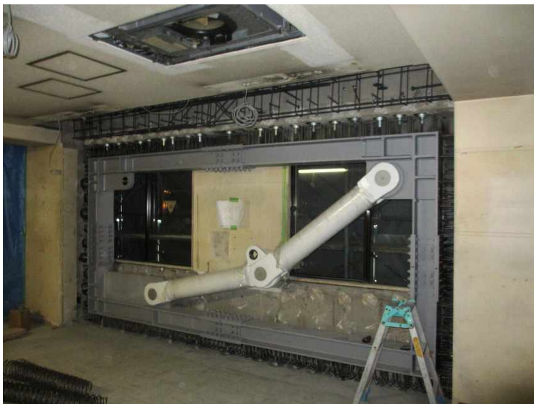
移転先3階の耐震、改修工事現場
